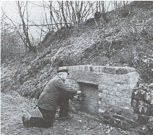
Nach der Instandsetzung des alten Quellbrunnens (1965) Fotograf/Urheber: Stefan Kronsbein
