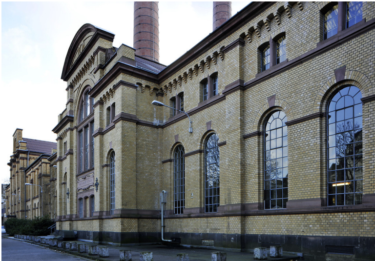
Kraft- und Wasserwerk Zugweg (2018) Fotograf/Urheber: Jürgen Gregori
