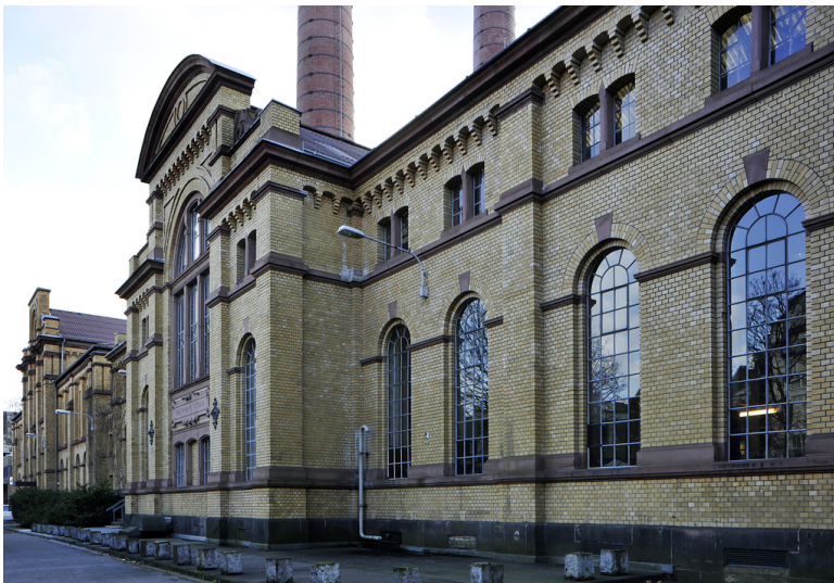
Kraft- und Wasserwerk Zugweg (2018) Fotograf/Urheber: Jürgen Gregori
