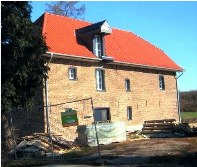
Saniertes Gebäude der Willikschen Mühle in Geldern (2019) Fotograf/Urheber: Hans-Michael Altemüller
