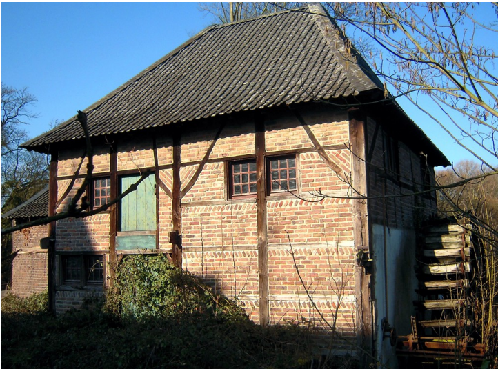
Fachwerkgebäude der Wassermühle bei Haus Caen (2016) Fotograf/Urheber: Hans-Michael Altemüller
