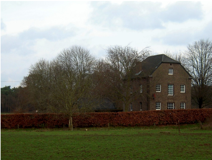
Backsteingebäude der Hoenselaerer Mühle (2016) Fotograf/Urheber: Hans-Michael Altemüller
