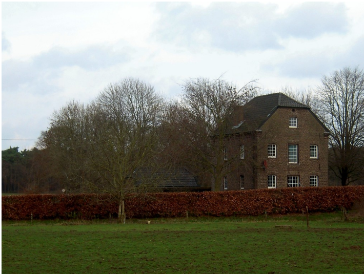
Backsteingebäude der Hoenselaerer Mühle (2016) Fotograf/Urheber: Hans-Michael Altemüller
