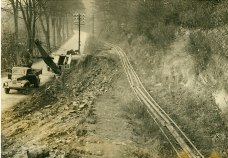
Alte Gleiszufahrt zum Steinbruch Eichhardt bei Wiehl. (1957) Fotograf/Urheber: unbekannt
