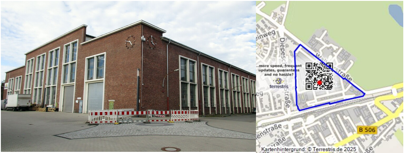
Die dreischiffige Sprinklerhalle der einstigen Firma Walther & Cie bzw. Total Walther GmbH mit ihrer von zahlreichen Fenstern durchbrochenen Backsteinfassade im heutigen Gewerbe- und Industriegebiet "Leskan Park" an der Waltherstraße in Köln-Dellbrück (2022) Fotograf/Urheber: Franz-Josef Knöchel
