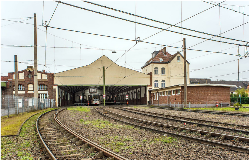
Straßenbahndepot Thielenbruch (2018) Fotograf/Urheber: Jürgen Gregori
