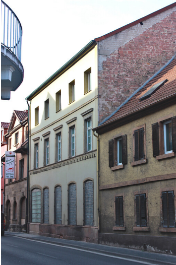
Außenansicht ehemaliges Triftamt Neustadt Fotograf/Urheber: Antonia Weber
