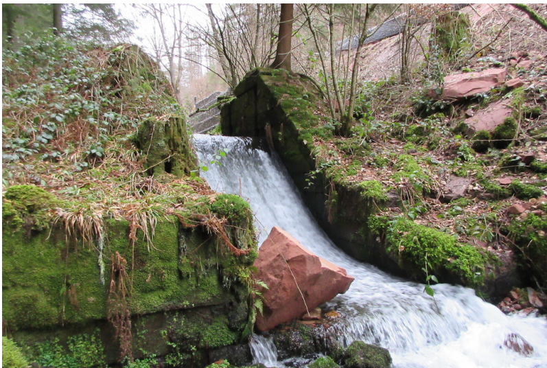
Scheerwoog mit unmittelbar anschließender Sohlrampe Fotograf/Urheber: Matthias Dreyer
