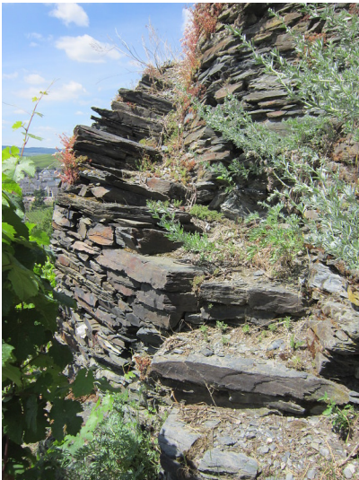
Weinbergmauer mit Treppe am Trittenheimer Fährfels (2014) Fotograf/Urheber: Marlene Bollig
