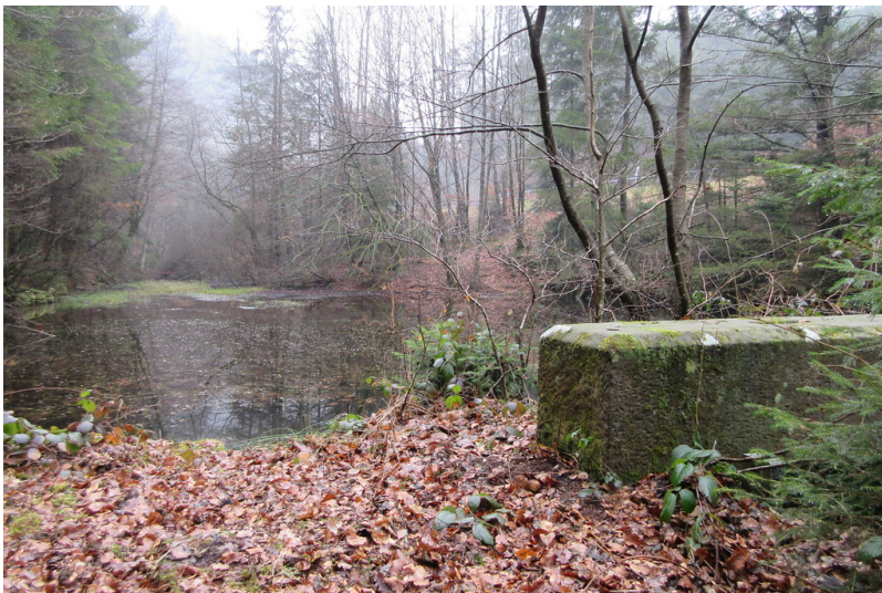
Mühlwoog mit Absperr- und Auslaufbauwerk Fotograf/Urheber: Matthias Dreyer
