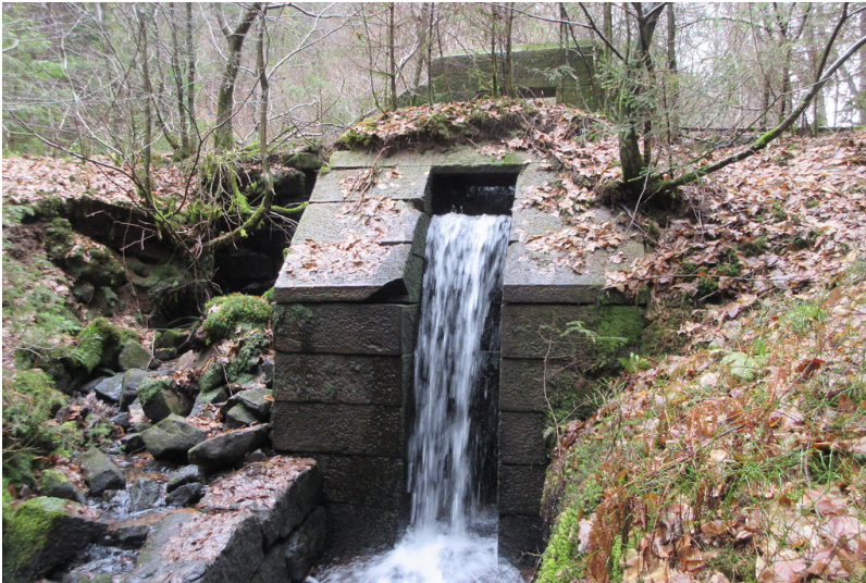
Dammbereich Fotograf/Urheber: Matthias Dreyer
