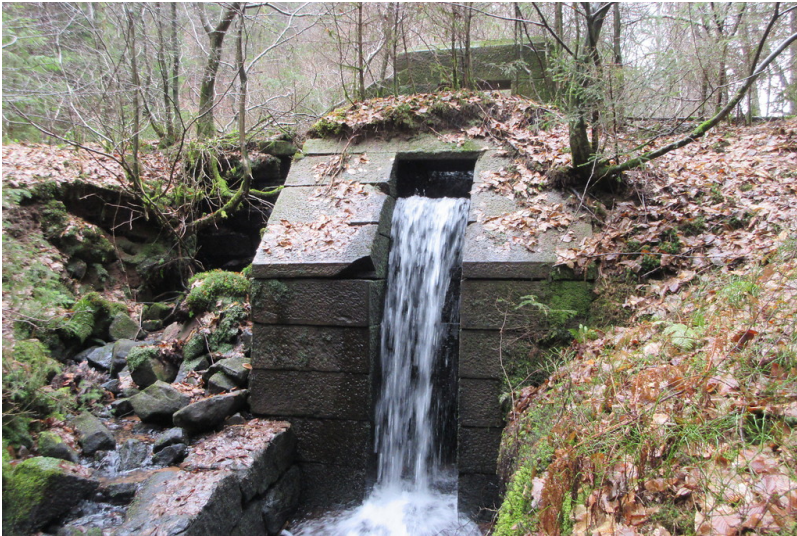
Dammbereich Fotograf/Urheber: Matthias Dreyer
