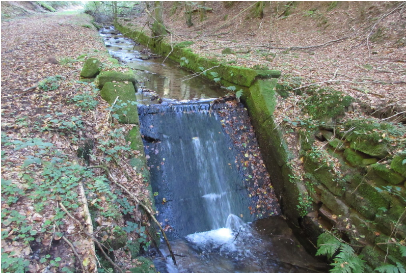
Sohlrampe am Wartenbach Fotograf/Urheber: Matthias Dreyer
