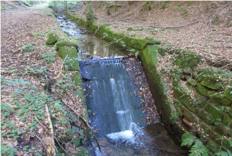
Sohlrampe am Wartenbach Fotograf/Urheber: Matthias Dreyer
