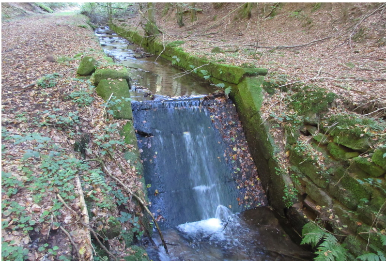
Sohlrampe am Wartenbach Fotograf/Urheber: Matthias Dreyer
