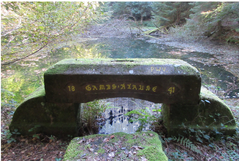
Wasserbauwerk Gambs-Klause im Pfälzerwald (2018) Fotograf/Urheber: Matthias C.S. Dreyer
