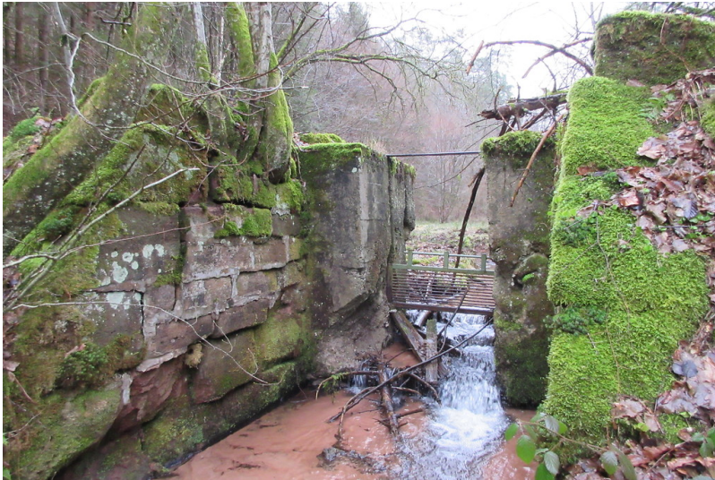
Dammdurchlass am Kaderwoog Fotograf/Urheber: Matthias Dreyer
