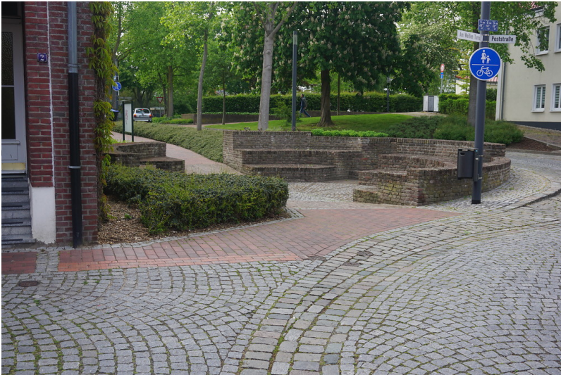
Rees, Rhinwicker Tor, Blick aus der Innenstadt (2019) Fotograf/Urheber: Claus Weber
