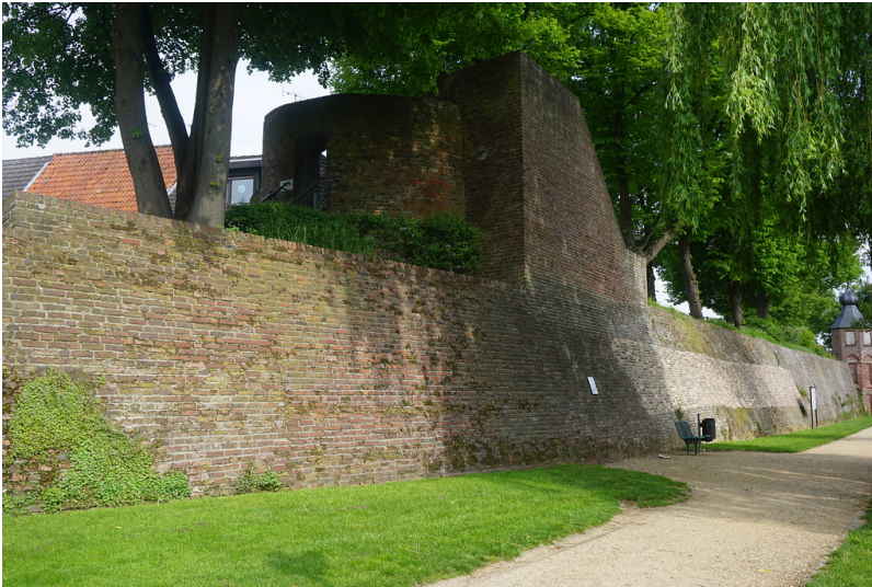
Reeser Stadtmauer an der Rheinfront, Weißer Turm (2019) Fotograf/Urheber: Claus Weber
