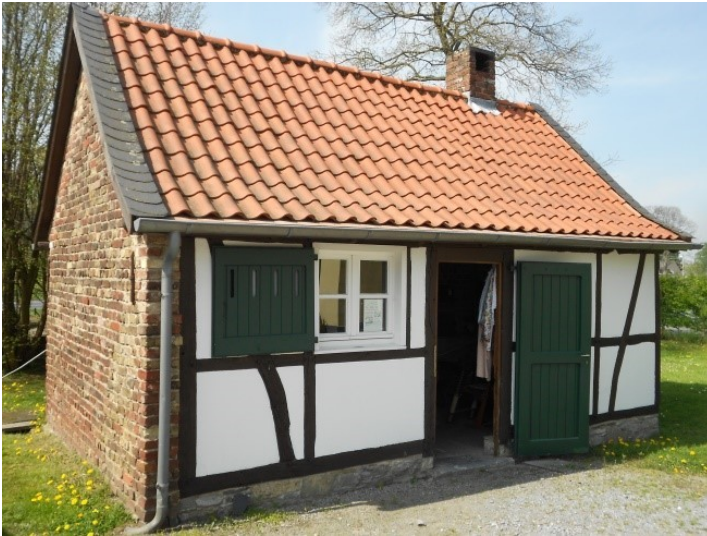
Hof Schink in Erkrath-Hochdahl (2019) Fotograf/Urheber: Horst-Ulrich Osmann
