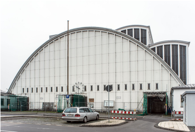
Ansicht der Großmarkthalle in Köln-Raderberg gen Westen (2018). Fotograf/Urheber: Jürgen Gregori
