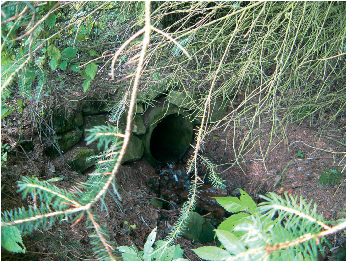
Ein in den Boden eingelassenes und mit Bruchsteinen eingefasstes Rohr leitet den Prether Bach weiter (2005). Fotograf/Urheber: Marietta Schmitz
