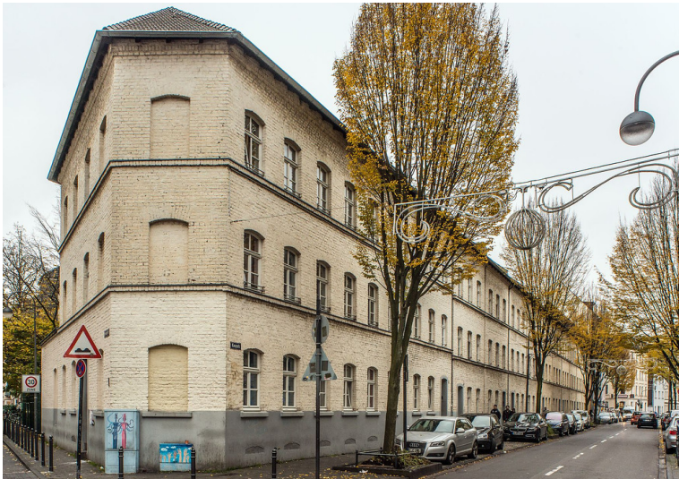
Felten & Guillaume Werkssiedlung in Köln-Mülheim (2018) Fotograf/Urheber: Jürgen Gregori
