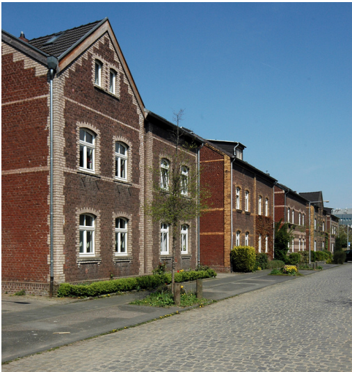
Spiegelglaswerke Germania in Höhenberg (2018) Fotograf/Urheber: Walter Buschmann
