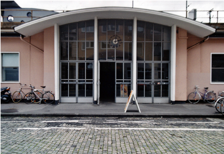
Eingang des Bahnhofs Köln-Süd (2018) Fotograf/Urheber: Walter Buschmann
