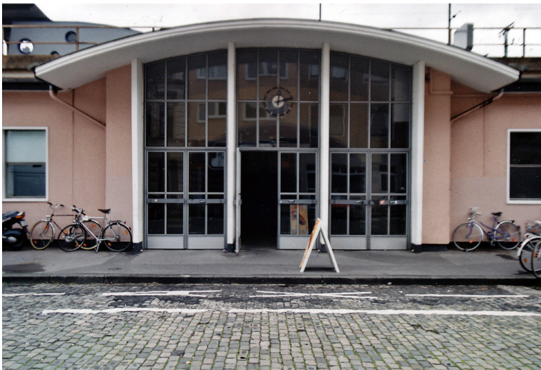
Eingang des Bahnhofs Köln-Süd (2018) Fotograf/Urheber: Walter Buschmann
