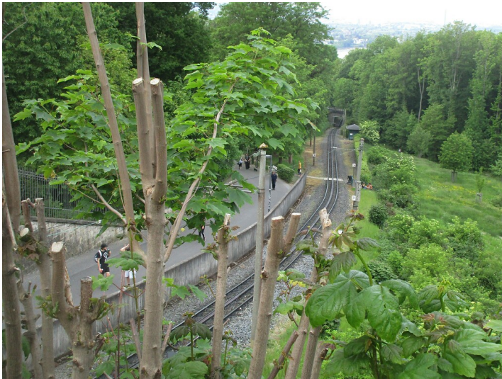
Blick auf die Gleise der Drachenfelsbahn an der Vorburg des Schlosses Drachenburg im Siebengebirge (2020). Fotograf/Urheber: Franz-Josef Knöchel
