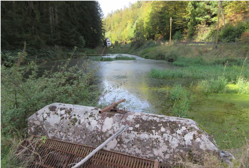
Speyerbrunner Woog mit Absperr- und Auslaufbauwerk Fotograf/Urheber: Matthias Dreyer
