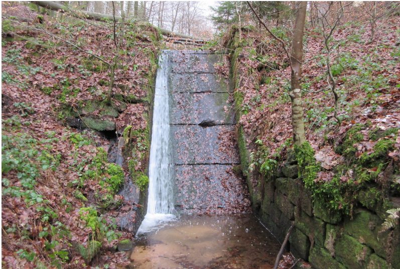
Sohlrampe Fotograf/Urheber: Matthias Dreyer
