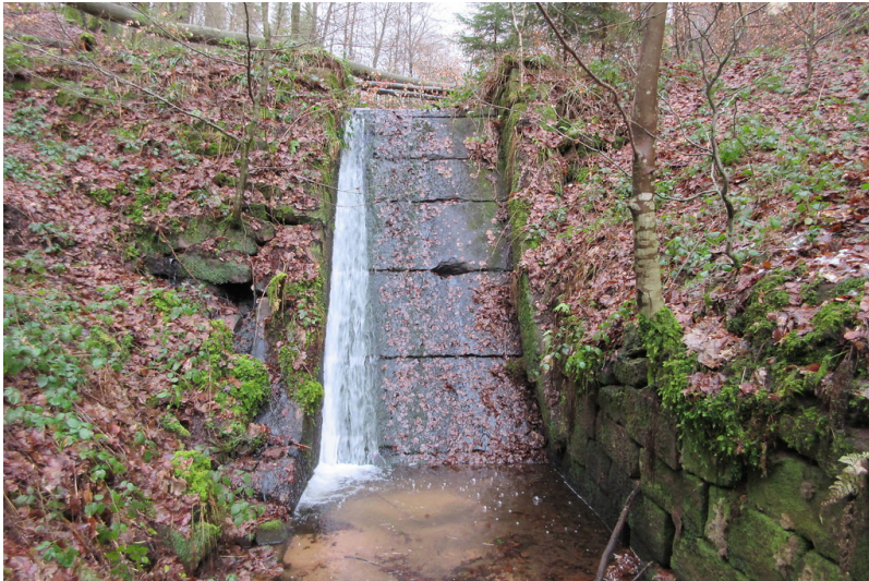
Sohlrampe Fotograf/Urheber: Matthias Dreyer
