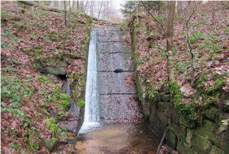
Sohlrampe Fotograf/Urheber: Matthias Dreyer
