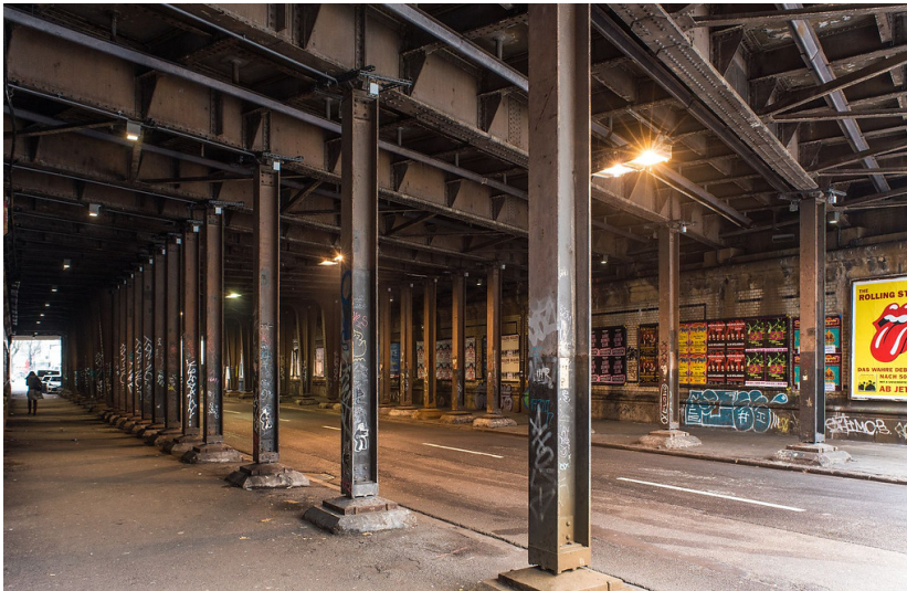
Brücke der Kölner Ringbahn an der Maybachstraße (2018) Fotograf/Urheber: Jürgen Gregori
