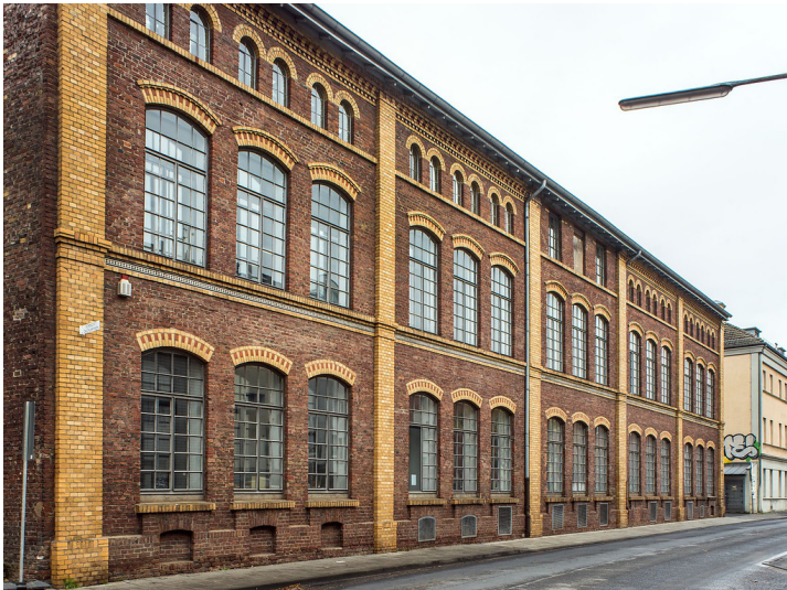
Accumulatorenfabrik Gottfried Hagen (2018) Fotograf/Urheber: Jürgen Gregori
