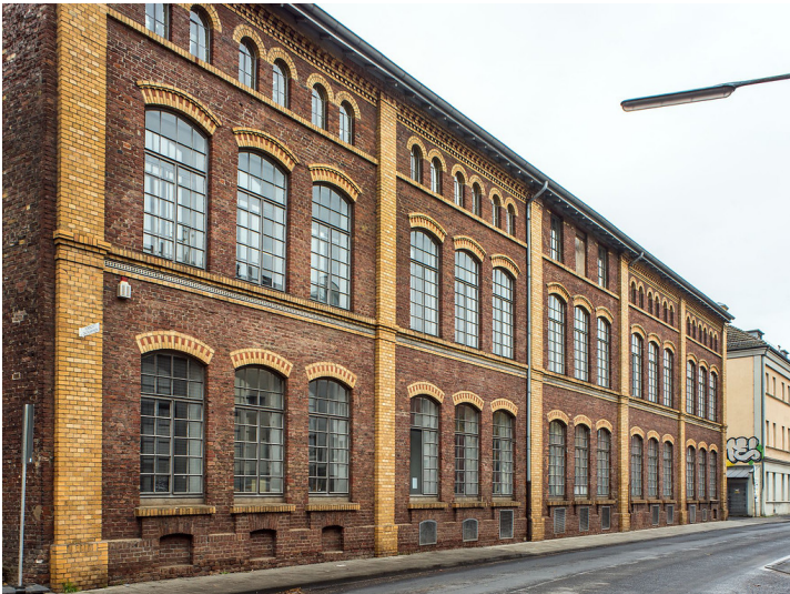
Accumulatorenfabrik Gottfried Hagen (2018) Fotograf/Urheber: Jürgen Gregori
