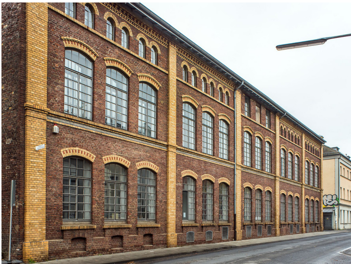
Accumulatorenfabrik Gottfried Hagen (2018) Fotograf/Urheber: Jürgen Gregori
