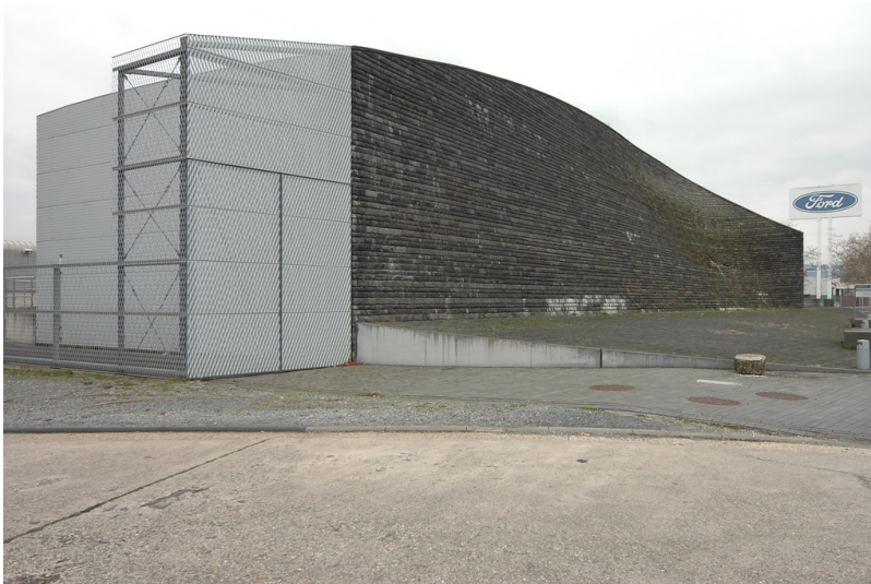
Pumpwerk Sankt-Leonardus-Straße (2018) Fotograf/Urheber: Walter Buschmann
