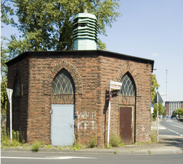
Transformatorstation in Köln-Niehl (2018) Fotograf/Urheber: Walter Buschmann
