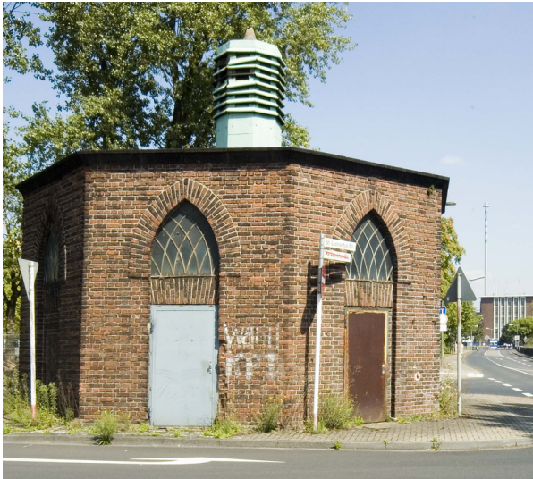
Transformatorstation in Köln-Niehl (2018) Fotograf/Urheber: Walter Buschmann
