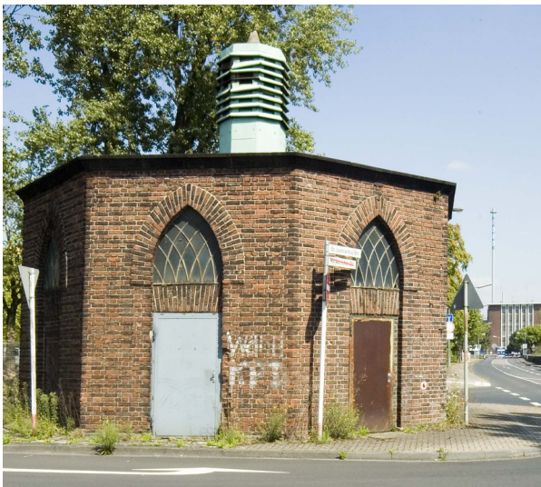
Transformatorstation in Köln-Niehl (2018) Fotograf/Urheber: Walter Buschmann
