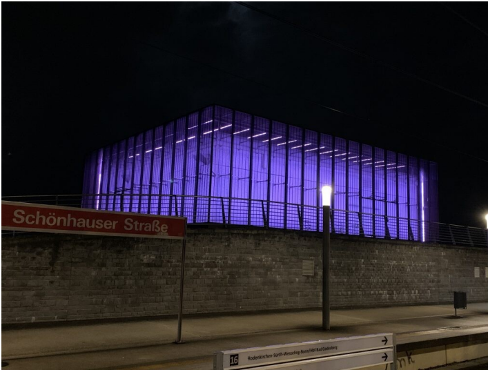
Das Hochwasserpumpwerk Schönhauser Straße in Köln-Bayenthal (2021), die blaue Illumination bedeutet "Pegel unter 2,4 Meter". Fotograf/Urheber: Uli Kievnagel
