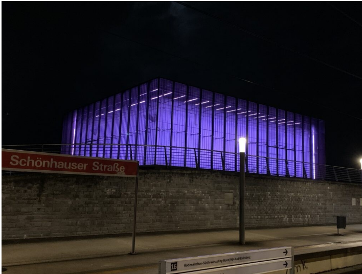
Das Hochwasserpumpwerk Schönhauser Straße in Köln-Bayenthal (2021), die blaue Illumination bedeutet "Pegel unter 2,4 Meter". Fotograf/Urheber: Uli Kievnagel
