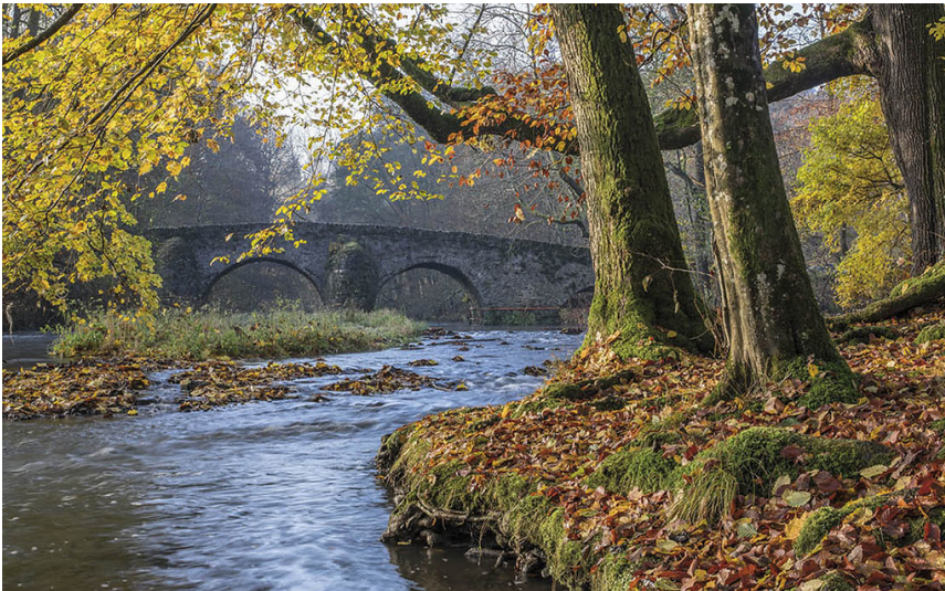
Nisterbrücke bei Hachenburg (2018) Fotograf/Urheber: klaes-images / Markus Monreal
