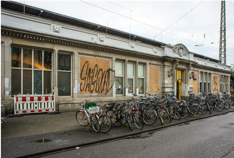
Bahnhof Köln-West (2018) Fotograf/Urheber: Walter Buschmann
