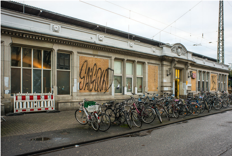
Bahnhof Köln-West (2018) Fotograf/Urheber: Walter Buschmann
