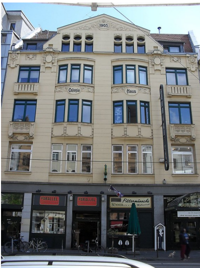
Das 1905 erbaute "Colonia Haus" in der Aachener Straße am Kölner Rudolfplatz, bis 2018 Spielstätte des "Millowitsch-Theaters" (2013) Fotograf/Urheber: Ninjamask
