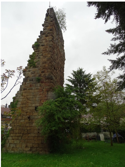
Burgruine Odenbach - Weiherturm (2019) Fotograf/Urheber: Matthias C.S. Dreyer
