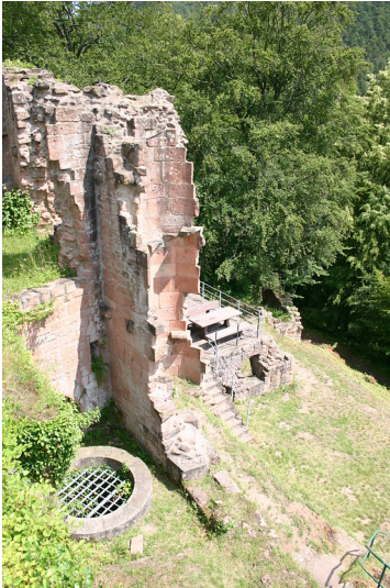
Treppenturm und Zisterne Fotograf/Urheber: Ulrich Burkhardt
