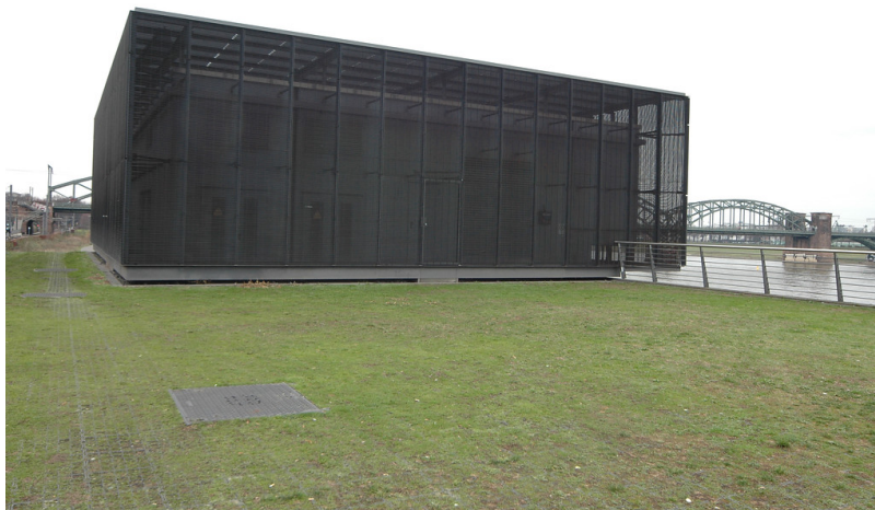
Hochwasserpumpwerk Schönhauser Straße (2018) Fotograf/Urheber: Walter Buschmann
