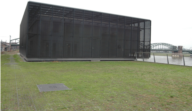
Hochwasserpumpwerk Schönhauser Straße (2018) Fotograf/Urheber: Walter Buschmann
