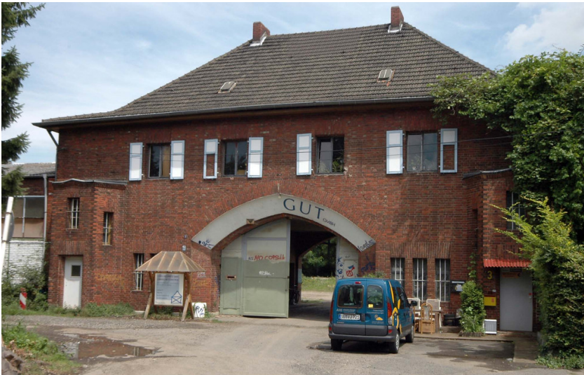
Mülheimer Hafen - Bauunternehmung Gebr. Meyer (2018) Fotograf/Urheber: Walter Buschmann
