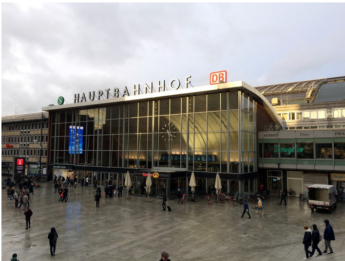
Empfangsgebäude des Kölner Hauptbahnhofs mit dem Bahnhofsvorplatz von Südwesten aus gesehen (2019) Fotograf/Urheber: Elmar Knieps
