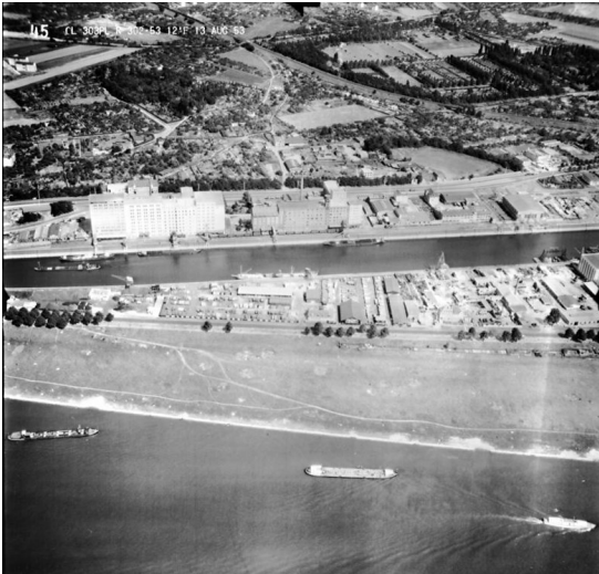
Luftbild von 1953: Das Rheinufer in Köln-Deutz mit der Auer-Mühle und Sportanlagen am früheren Fort Rauch.
