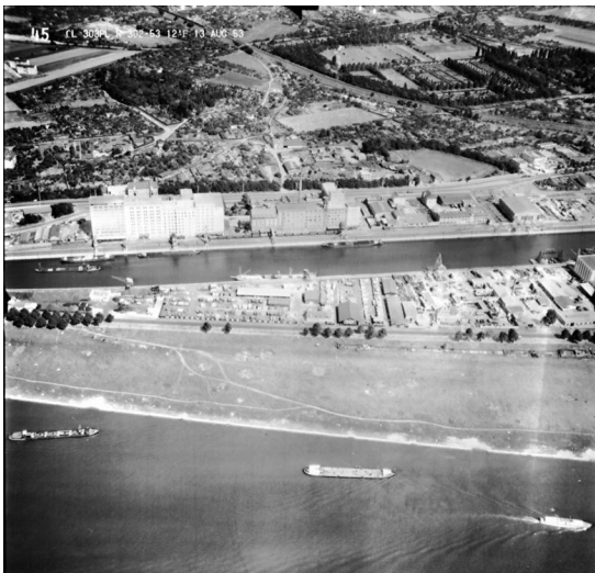
Luftbild von 1953: Das Rheinufer in Köln-Deutz mit der Auer-Mühle und Sportanlagen am früheren Fort Rauch.
