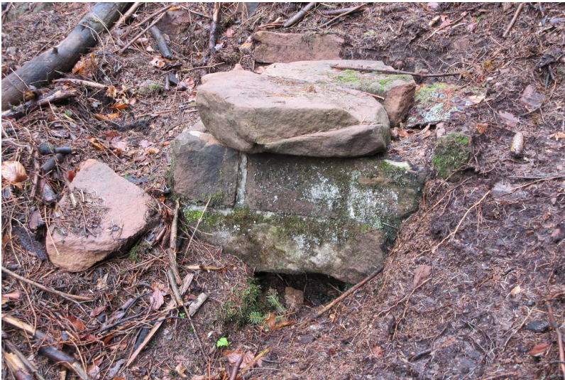
Relikt des Sandsteinmauerwerks am Riesenwoog am Warzbach (2018) Fotograf/Urheber: Matthias C.S. Dreyer
